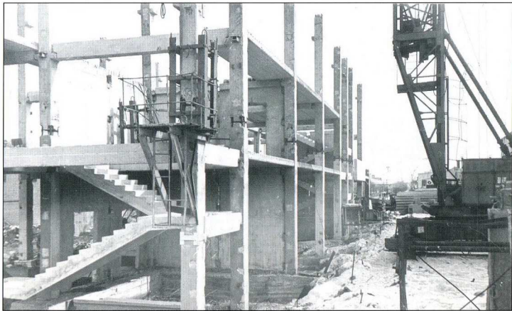
Строительство инженерного корпуса, 1984 г.
