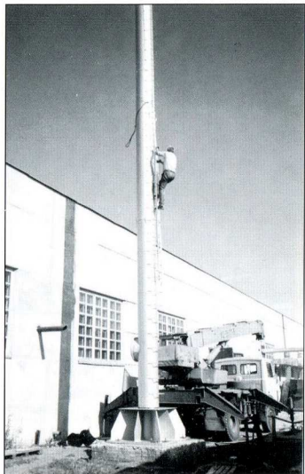
Монтаж выхлопной системы стендов новой испытательной станции, 2003 г.
